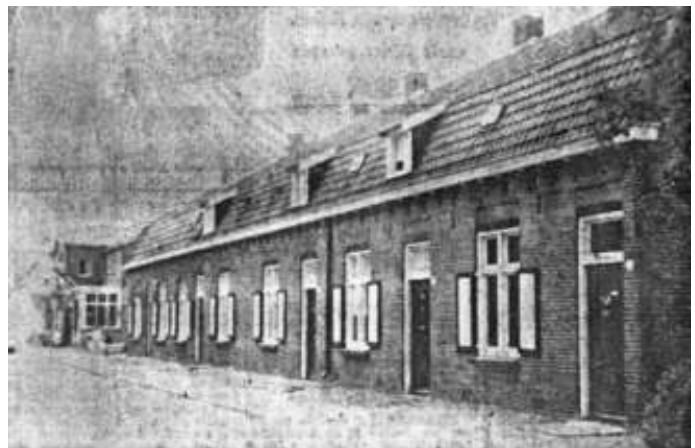
Na de brand werden deze huizen gebouwd op de plaats waar het huis van Raaijmakers en Manders stond.
